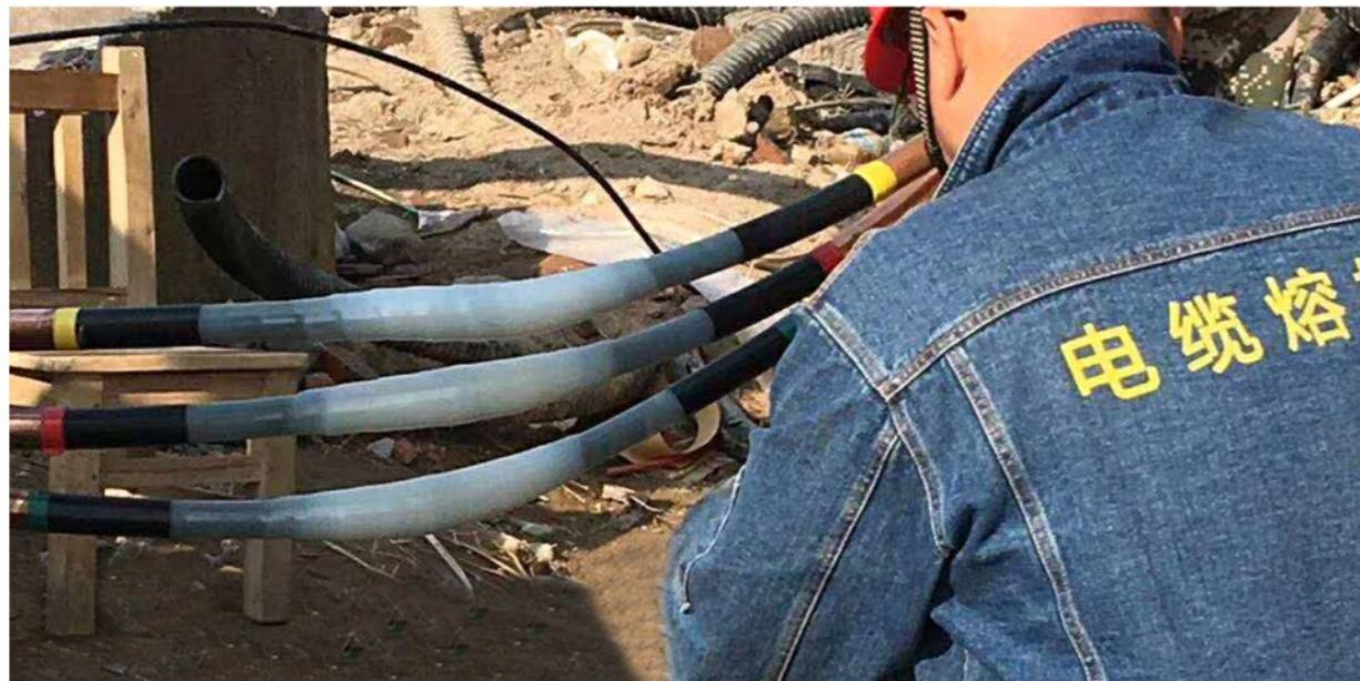
(3) 打磨铜(铝)线芯、剥离内屏蔽、绝缘
